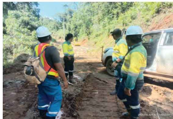
Pembangunan bendungan & saluran irigasi di Desa Tirawonua oleh SCM.
